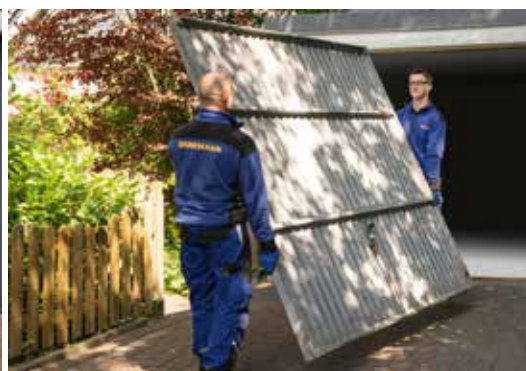
Ausbau und umweltgerechte Entsorgung
